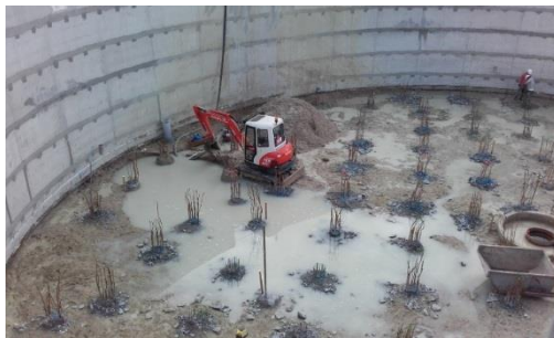
Construction du bassin d'orage de La Ferté-Saint-Aubin
