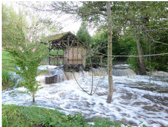
La crue de l'Ardoux à Ardon en 2016
