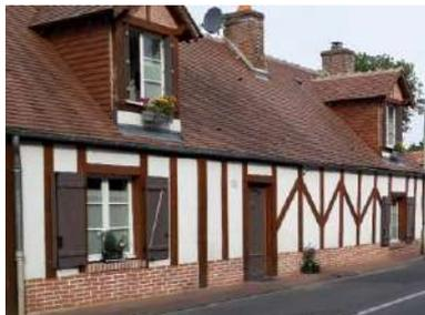
**Figure 138.** Utilisation de la brique en soubassement
