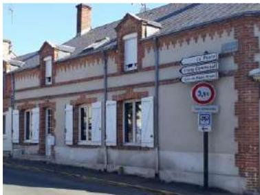
**Figure 139.** Utilisation de la brique en chaîne d'angle et encadrement
