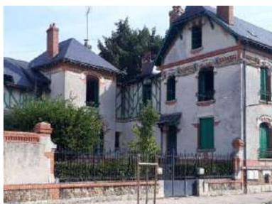
**Figure 141.** Utilisation de la brique pour souligner les ouvertures et corniches
