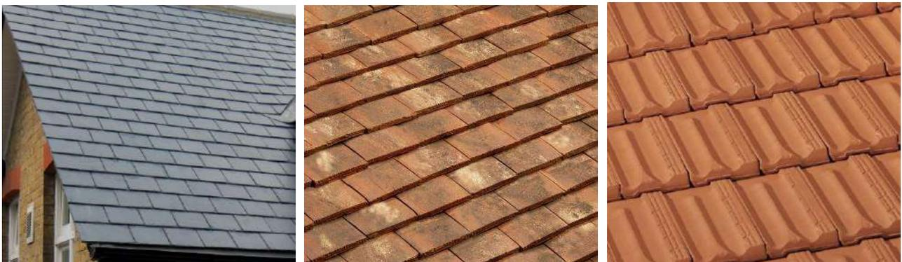
**Figure 145.** Matériaux de toiture de la Sologne, respectivement ardoise / tuile plate / tuile Camille Berthier
