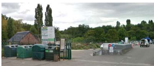
Déchetterie de La Ferté Saint-Aubin
